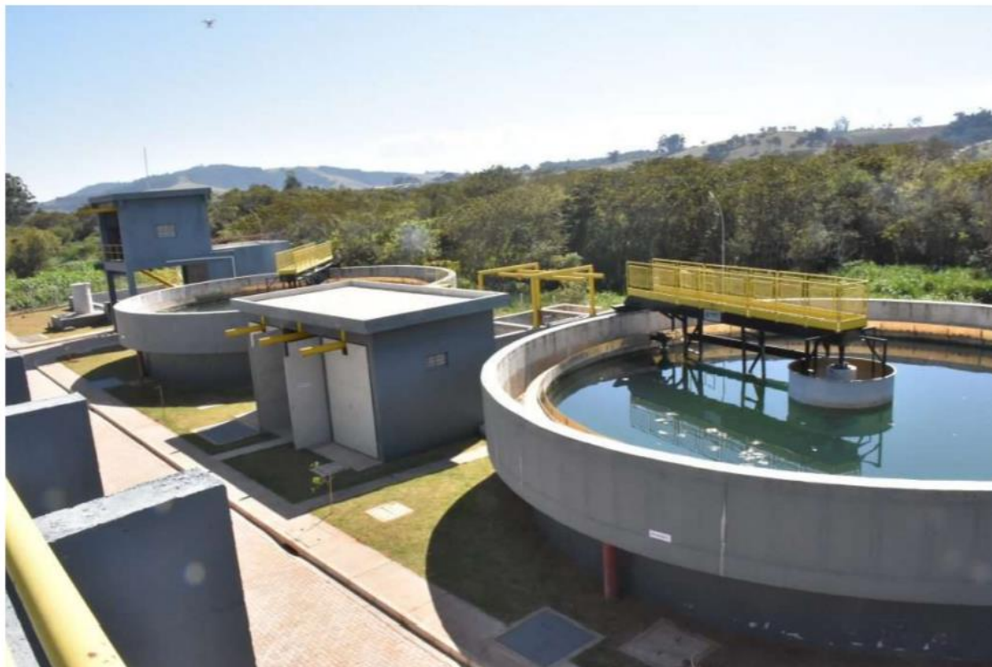
Figura 7 – Estação de Tratamento de Esgoto de Bom Jesus dos Perdões
